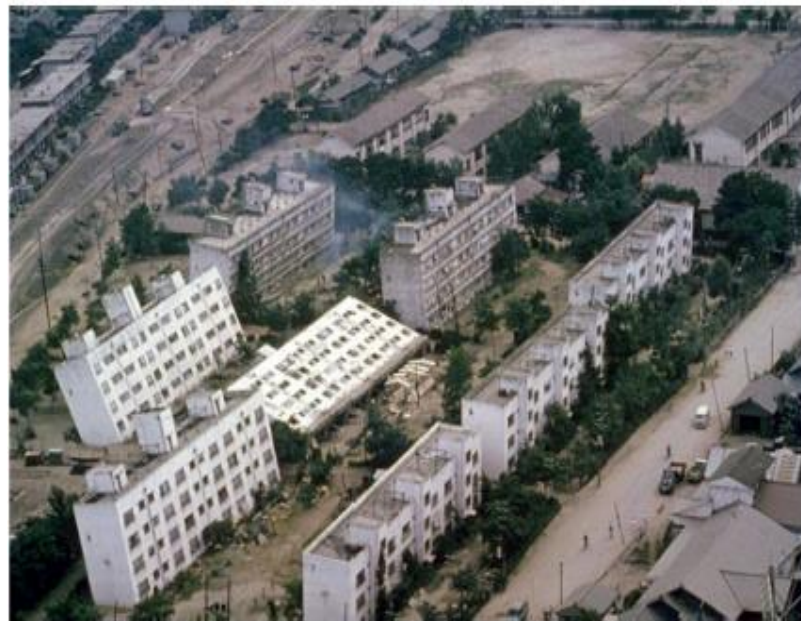
Рис. 13.3. Опрокидывание зданий из-за разжижения грунта
