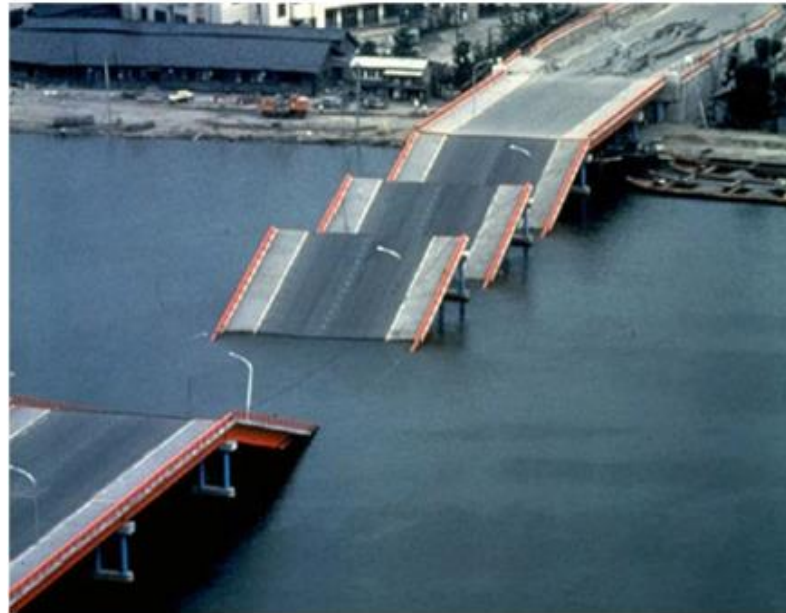
Рис. 13.5. Обрушение пролетов моста
