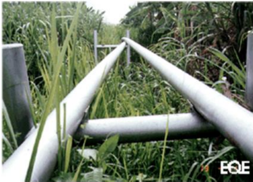
Рис. 13.8. Смещение незаанкеренных трубопроводов
