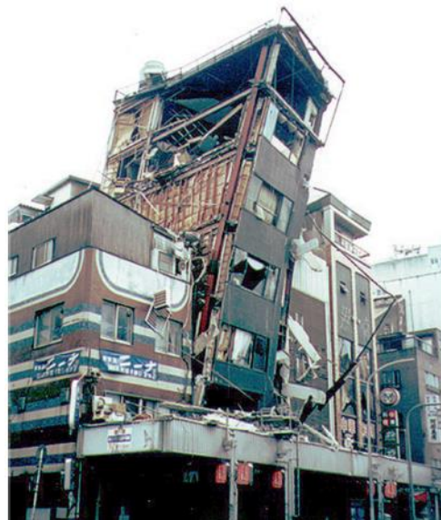
Рис. 13.17. Деформации бессвязевого каркаса
