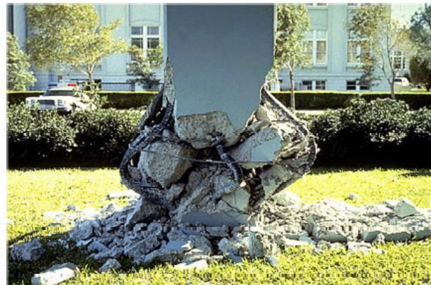
Рис. 13.9. Разрушение колонн нижнего этажа вертикальной составляющей сейсмической нагрузки
