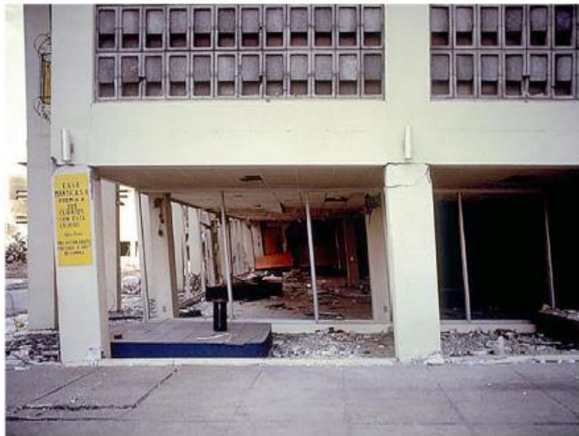
Рис. 13.2. Разрушение здания из-за гибкого этажа
