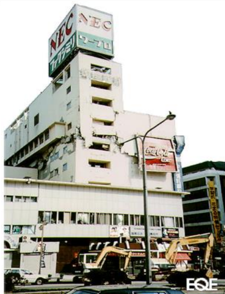
Рис. 13.16. Повреждение здания с большими перепадами по высоте
