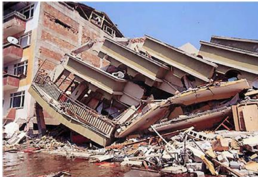
Рис. 13.7. Пример разрушения здания с каменным заполнением каркаса (Турция)
